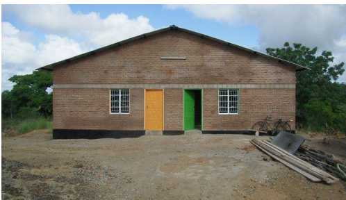
Das Gebäude für das 'Training Centre' (Ausbildungszentrum) steht bereits. Aktuell fehlt aber noch die Ausstattung
